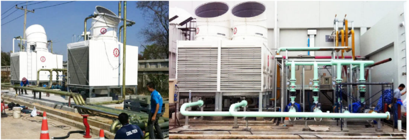
ติดตั้งหอระบายความร้อน (Cooling Tower), เครื่องสูบน้ำ (Water Pump) บริษัท ไทย ภูลิโกะ จำกัด | ปทุมธานี
